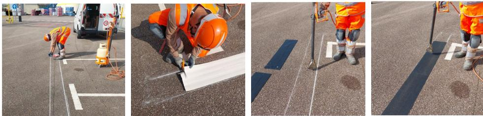
Poser l'AXIGUIDE sur la semelle tout en continuant à chauffer et en la compactant légèrement.
