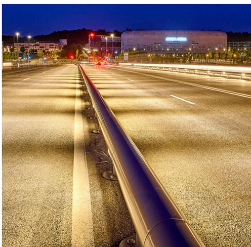
Le challenge à relever sur ce projet était de garder l'esthétisme des dispositifs de retenue en cylindre imaginés par l'architecte, tout en permettant un démontage total ou partiel de ces équipements.
