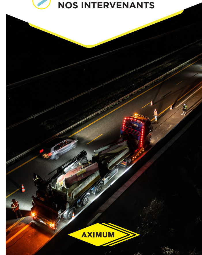
Radar à modulation de fréquence installé sur de la signalisation lumineuse remorquée
